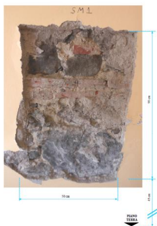
MURATURA IN BLOCCHI DI PIETRA NON SQUADRATI E SPORADICA PRESENZA DI PEZZAME DI MATTONI PIENI, CON RICORSI IN MATTONI PIENI - SPESORE MURATURA 43,0 CM COMPRESO INTONACO 3 CM
