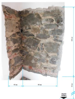
MURATURA IN BLOCCHI DI PIETRA NON SQUADRATI E SPORADICA PRESENZA DI PEZZAME DI MATTONI PIENI, CON RICORSI IN MATTONI PIENI - SPESORE MURO INTERNO 43,0 CM MURO ESTERNO 34,0 CM COMPRESO INTONACO 2 CM AMMORSAMENTO NON REGOLARE
