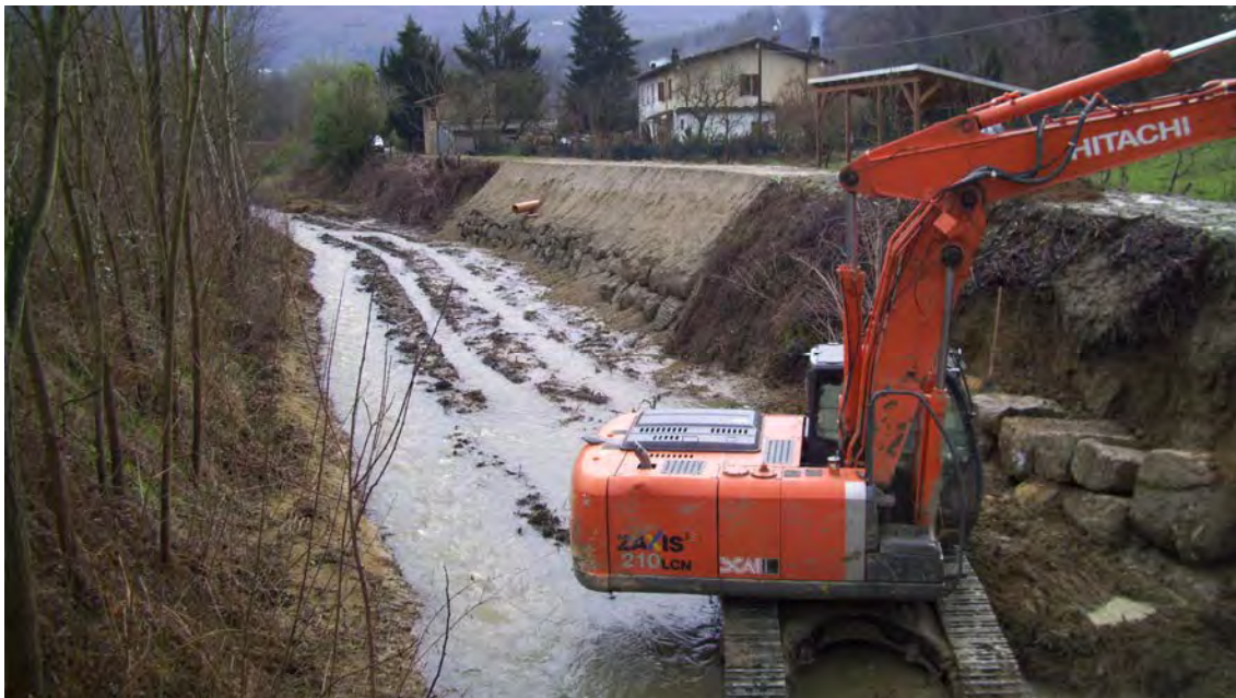
Foto n. 1, Foto n. 2: lavori in somma urgenza in loc. Vallone (febbraio 2011) e in loc. Grilaie
