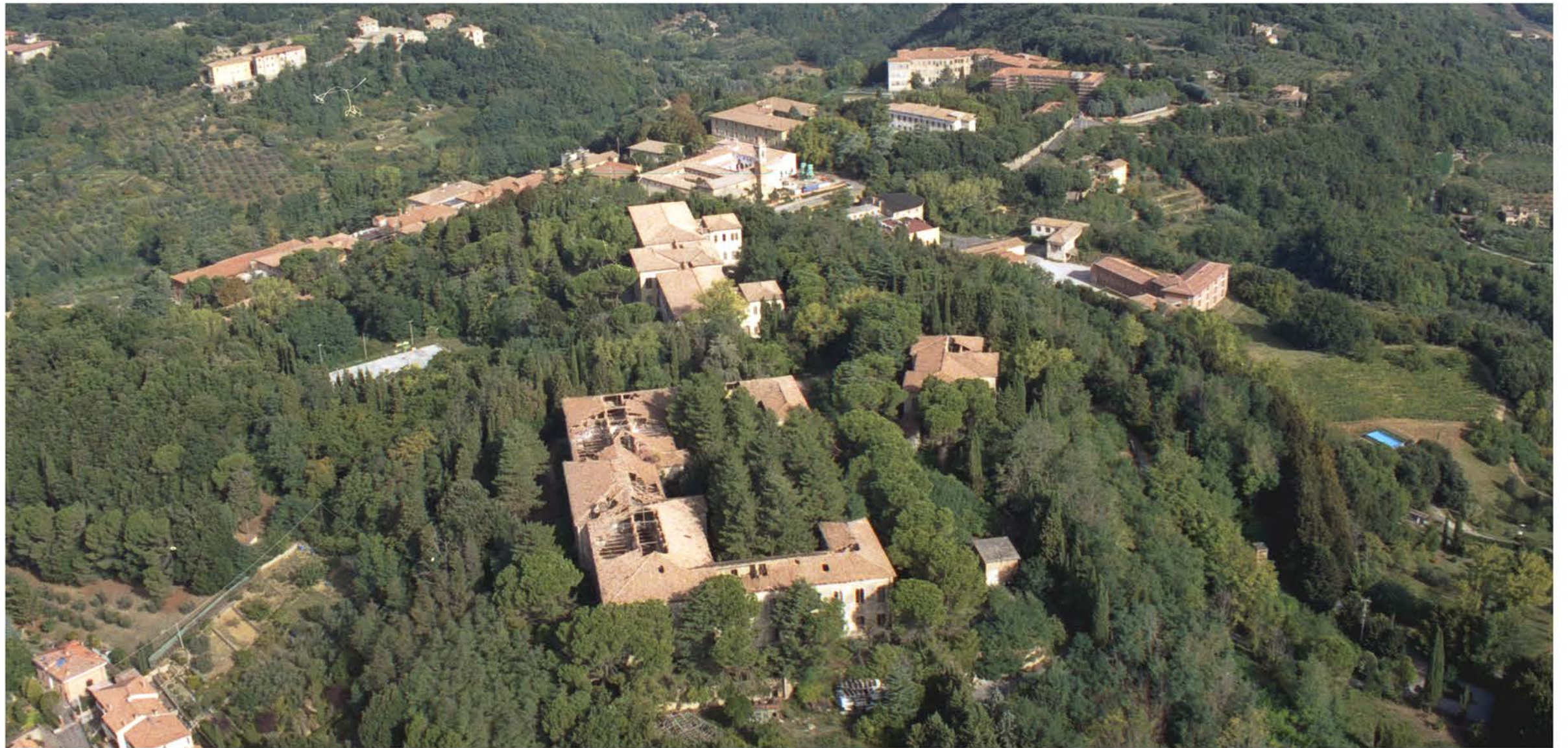
stato attuale: viste aeree del sito
