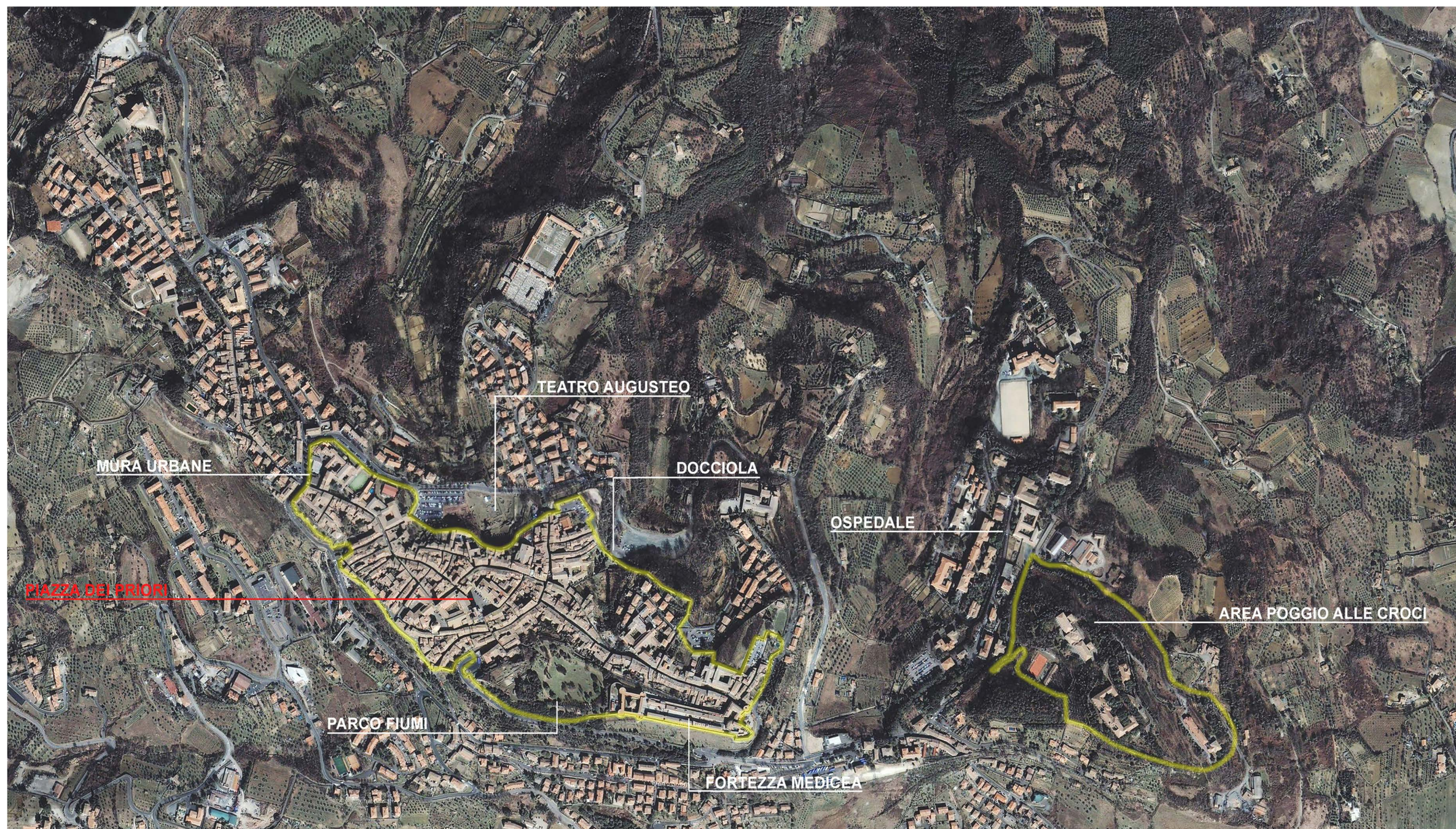
stato attuale: viste aeree del sito
