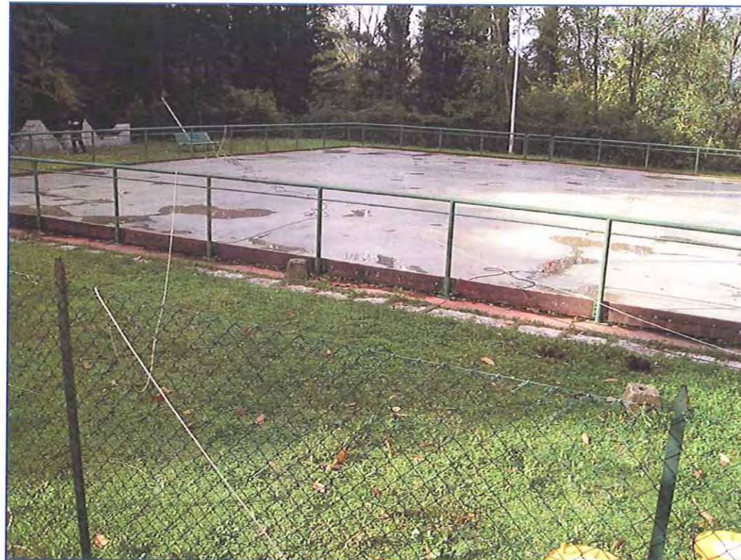
Profilo ST8: particolare di un tratto dello stendi mento
