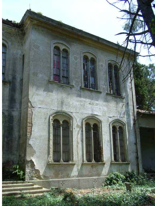
Il padiglione Maragliano nella corte di ingresso
