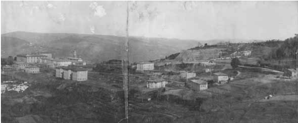
La collina del Poggio durante i lavori negli anni venti
