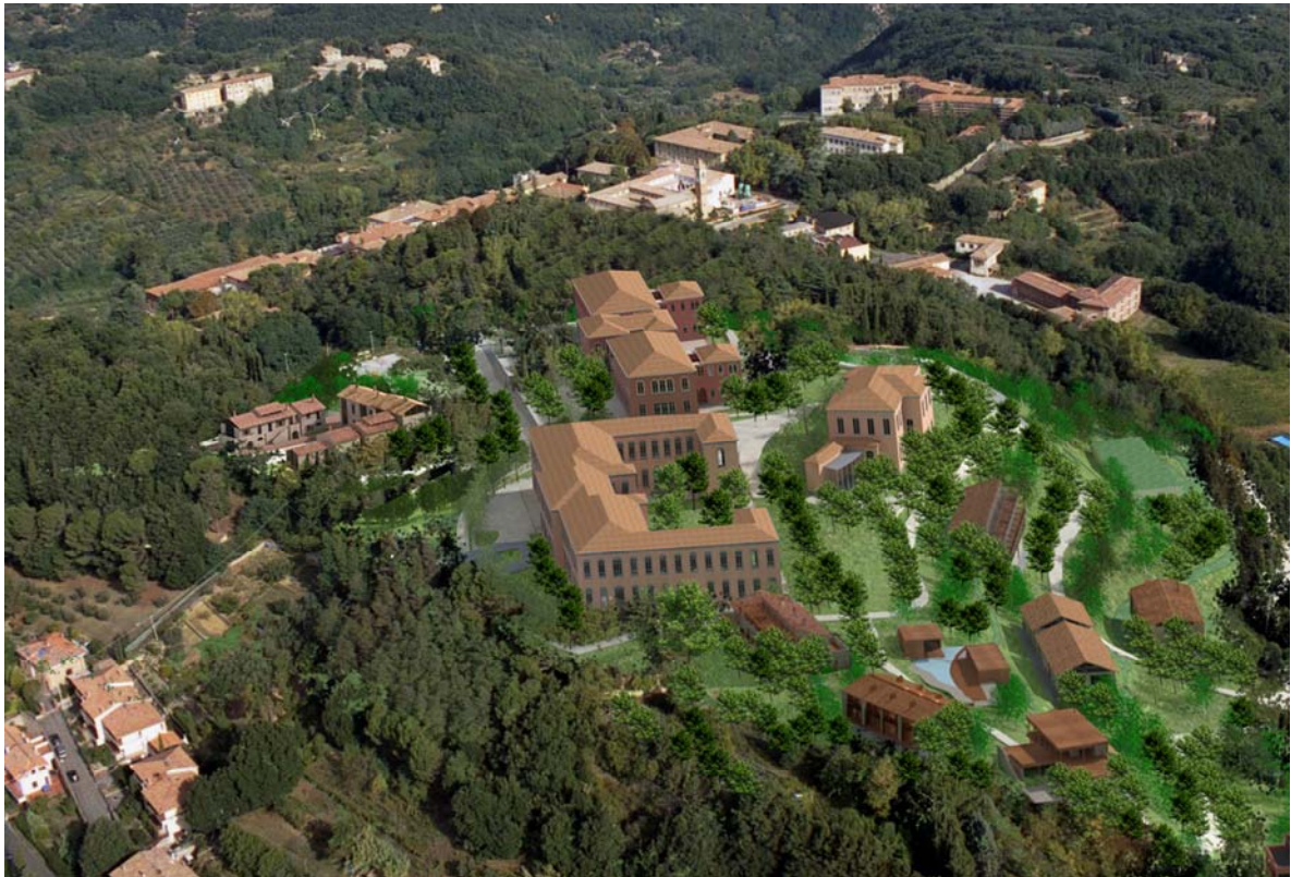
Stato di Progetto. L'area vista da sud ; in primo piano l'area delle serre e l'area ex sarteschi.
