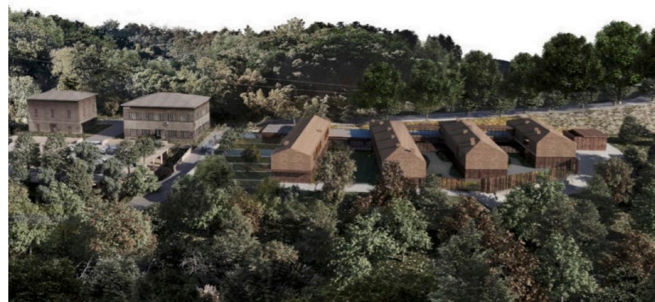
Vista generale dell'intervento
