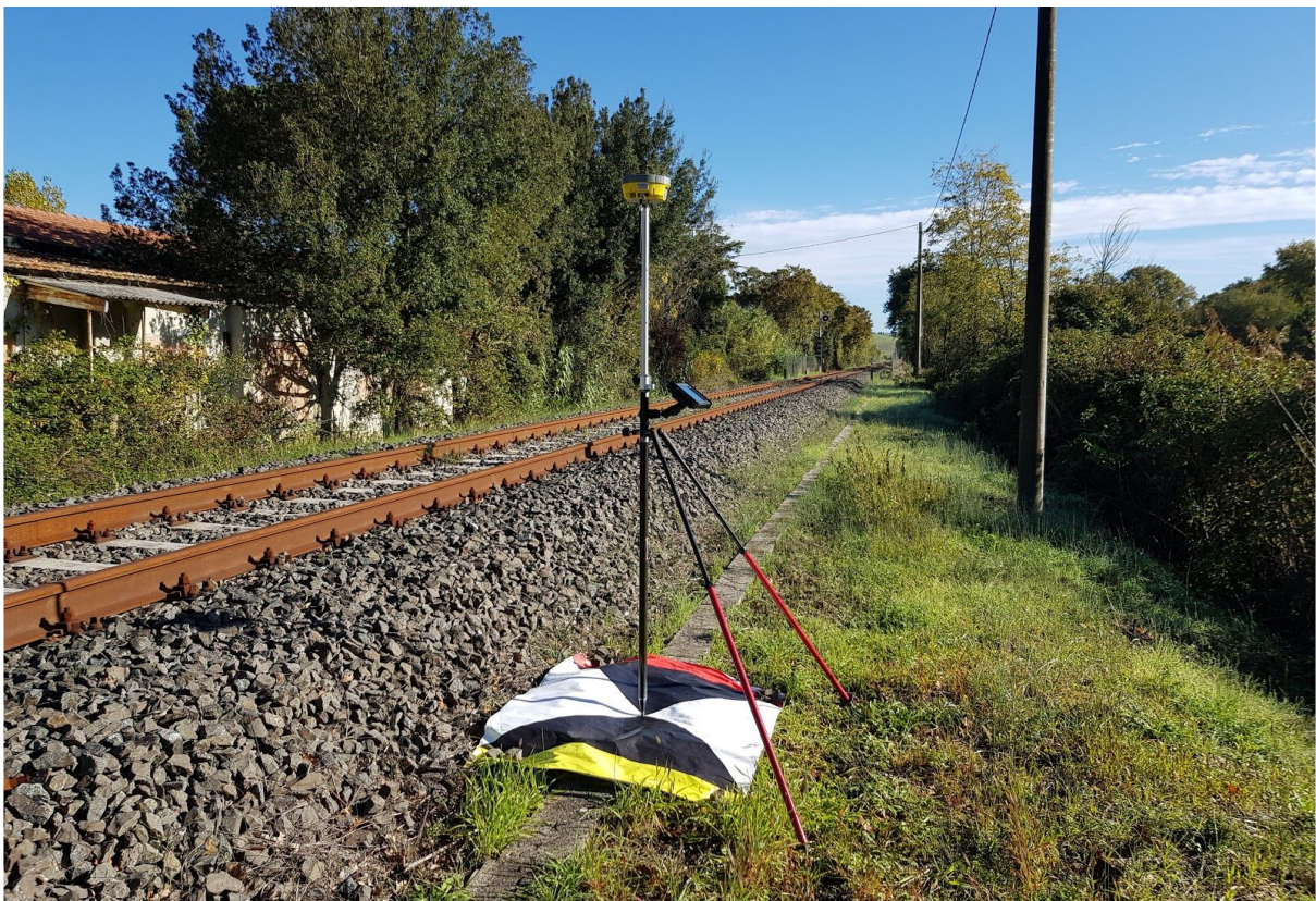
Target artificiali e rilievo GNSS della loro posizione
