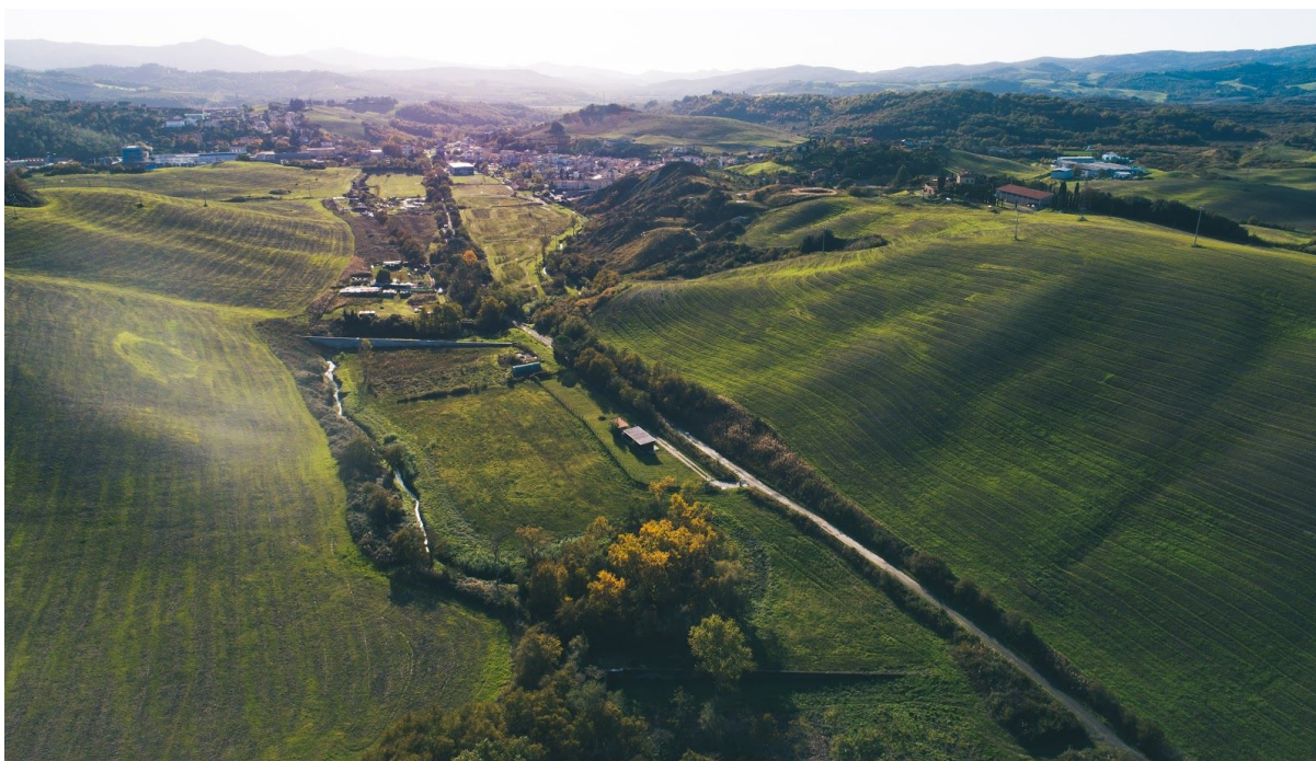
Foto aerea del Ramo Nord-Est dell'area oggetto di indagini
