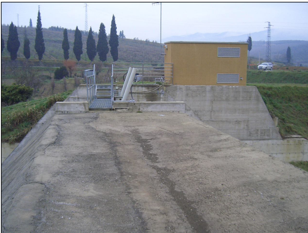
FIGURA 16. SOGLIA DI SFIORO
