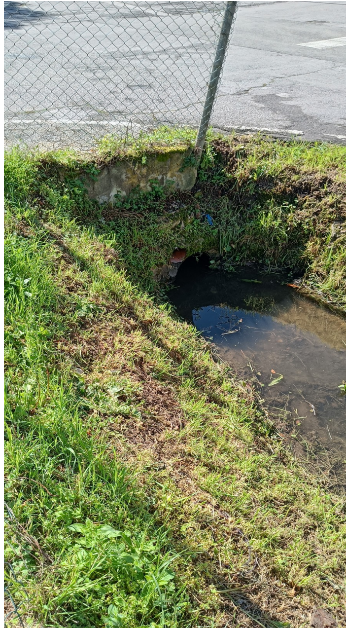
Figura 16: Attraversamento sottodimensionato
