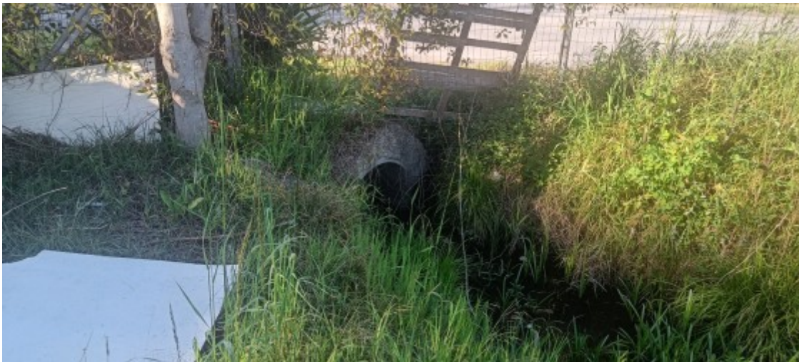
Figura 2: sbocco del tombamento TN37399
