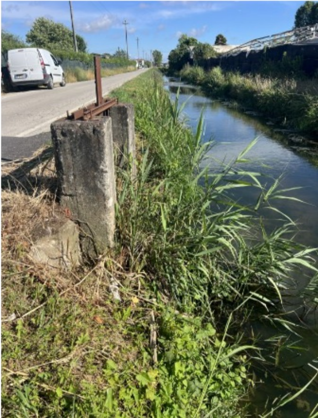
Figura 6: paratoia di derivazione ostruita
