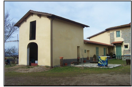
Foto: 03 Data ripresa: 23/02/2006 Edificio: 354/A File: 354-03.JPG
