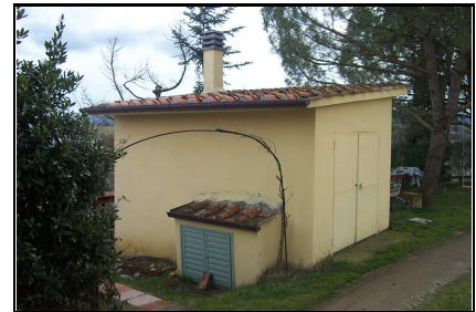
Foto: 09 Data ripresa: 23/02/2006 Edificio: 354/B File: 354-09.JPG
