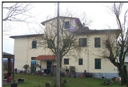
Foto: 11 Data ripresa: 23/02/2006 Edificio: 354 File: 354-11.JPG
