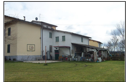
Foto: 06 Data ripresa: 23/02/2006 Edificio: 354 File: 354-06.JPG
