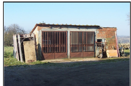
Foto: 09 Data ripresa: 10/02/2006 Edificio: 352/B File: 352-09.JPG
