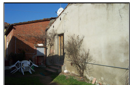
Foto: 12 Data ripresa: 10/02/2006 Edificio: 351/B File: 351-12.JPG
