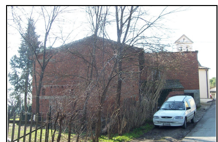
Foto: 15 Data ripresa: 10/02/2006 Edificio: 351/B File: 351-15.JPG
