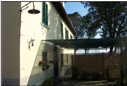
Foto: 04 Data ripresa: 10/02/2006 Edificio: 351/A File: 351-04.JPG
