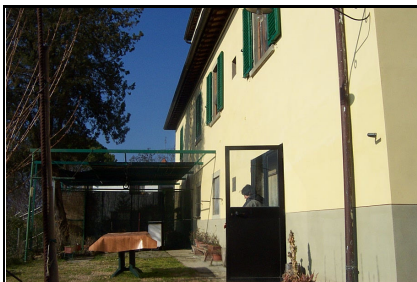
Foto: 07 Data ripresa: 10/02/2006 Edificio: 351/A File: 351-07.JPG
