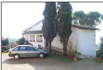
Foto: 05 Data ripresa: 10/02/2006 Edificio: 350/C File: 350-05.JPG
