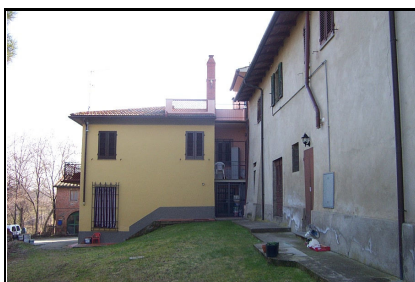
Foto: 08 Data ripresa: 10/02/2006 Edificio: 350/A File: 350-08.JPG
