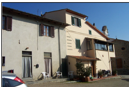
Foto: 02 Data ripresa: 10/02/2006 Edificio: 350 File: 350-02.JPG
