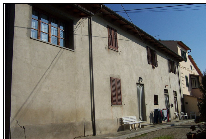
Foto: 06 Data ripresa: 10/02/2006 Edificio: 350/B File: 350-06.JPG
