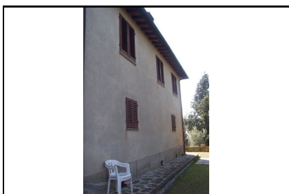
Foto: 07 Data ripresa: 10/02/2006 Edificio: 350/B File: 350-07.JPG
