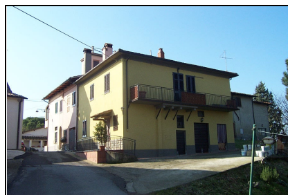
Foto: 03 Data ripresa: 10/02/2006 Edificio: 350/A File: 350-03.JPG
