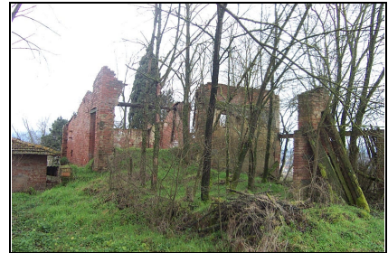
Foto: 06 Data ripresa: 22/02/2006 Edificio: 329/D File: 329-06.JPG
