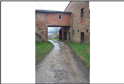
Foto: 04 Data ripresa: 22/02/2006 Edificio: 329/A File: 329-04.JPG
