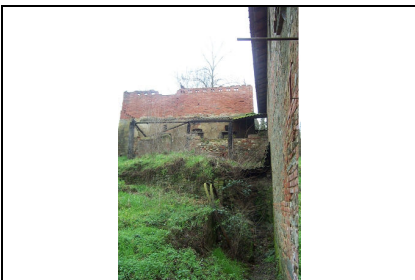
Foto: 13 Data ripresa: 22/02/2006 Edificio: 329/D File: 329-13.JPG
