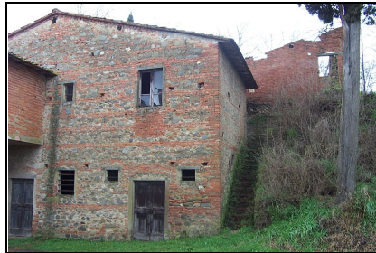
Foto: 05 Data ripresa: 22/02/2006 Edificio: 329/B File: 329-05.JPG
