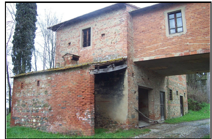
Foto: 12 Data ripresa: 22/02/2006 Edificio: 329/B File: 329-12.JPG
