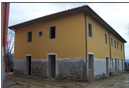
Foto: 05 Data ripresa: 20/02/2006 Edificio: 328/A File: 328-05.JPG
