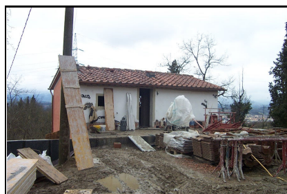
Foto: 09 Data ripresa: 20/02/2006 Edificio: 328/C File: 328-09.JPG
