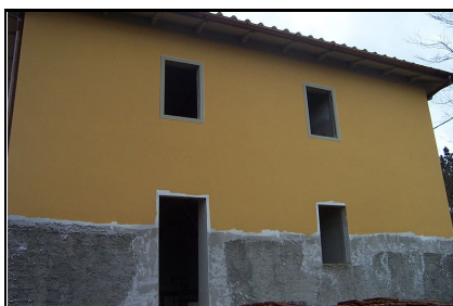
Foto: 07 Data ripresa: 20/02/2006 Edificio: 328/A File: 328-07.JPG
