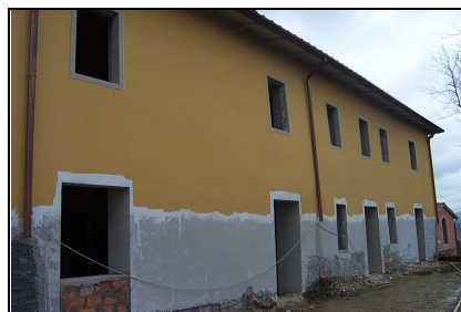
Foto: 06 Data ripresa: 20/02/2006 Edificio: 328/A File: 328-06.JPG
