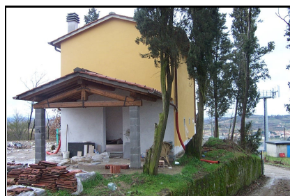
Foto: 12 Data ripresa: 20/02/2006 Edificio: 328/B File: 328-12.JPG
