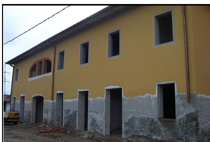
Foto: 08 Data ripresa: 20/02/2006 Edificio: 328/A File: 328-08.JPG
