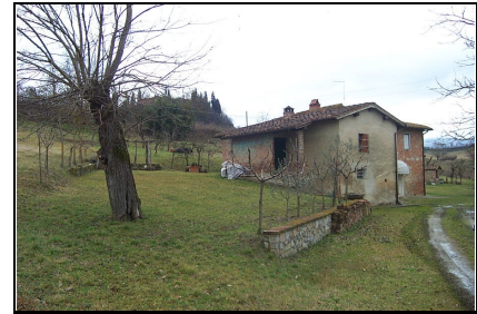
Foto: 03 Data ripresa: 22/02/2006 Edificio: 326/A File: 326-03.JPG
