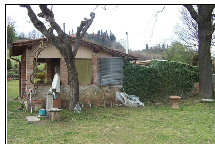
Foto: 18 Data ripresa: 22/02/2006 Edificio: 326/B File: 326-18.JPG
