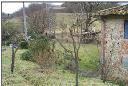
Foto: 10 Data ripresa: 22/02/2006 Edificio: 326/B File: 326-10.JPG
