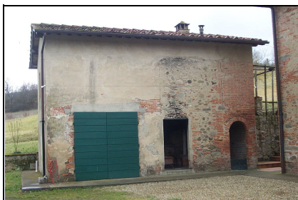
Foto: 19 Data ripresa: 22/02/2006 Edificio: 326/A File: 326-19.JPG
