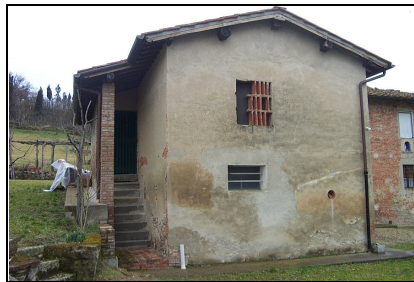
Foto: 05 Data ripresa: 22/02/2006 Edificio: 326/A File: 326-05.JPG
