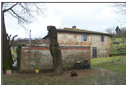
Foto: 17 Data ripresa: 22/02/2006 Edificio: 326/C File: 326-17.JPG
