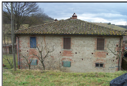
Foto: 11 Data ripresa: 22/02/2006 Edificio: 326 File: 326-11.JPG
