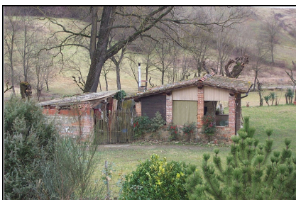
Foto: 13 Data ripresa: 22/02/2006 Edificio: 326/B File: 326-13.JPG
