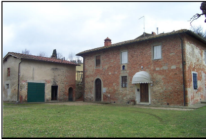
Foto: 01 Data ripresa: 22/02/2006 Edificio: 326 File: 326-01.JPG
