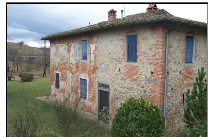
Foto: 12 Data ripresa: 22/02/2006 Edificio: 326 File: 326-12.JPG
