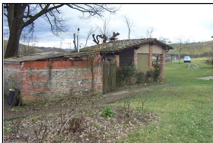
Foto: 16 Data ripresa: 22/02/2006 Edificio: 326/C File: 326-16.JPG
