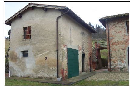
Foto: 06 Data ripresa: 22/02/2006 Edificio: 326/A File: 326-06.JPG
