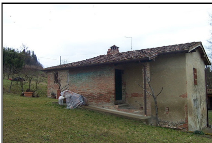
Foto: 07 Data ripresa: 22/02/2006 Edificio: 326/A File: 326-07.JPG
