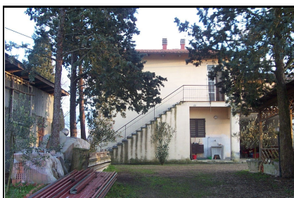
Foto: 07 Data ripresa: 20/02/2006 Edificio: 317/C File: 317-07.JPG
