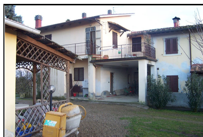
Foto: 09 Data ripresa: 20/02/2006 Edificio: 317/C File: 317-09.JPG
