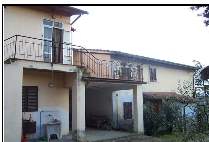
Foto: 08 Data ripresa: 20/02/2006 Edificio: 317/C File: 317-08.JPG
