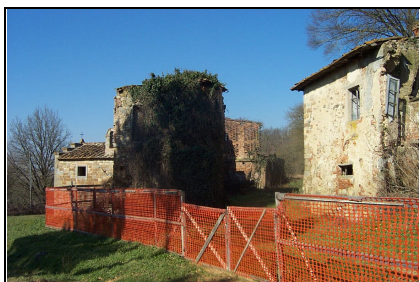
Foto: 04 Data ripresa: 14/02/2006 Edificio: 307/B File: 307-04.JPG
