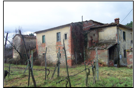
Foto: 03 Data ripresa: 21/02/2006 Edificio: 299 File: 299-03.JPG
