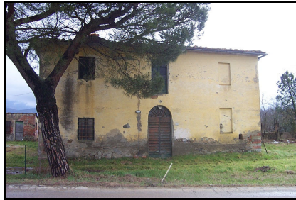
Foto: 02 Data ripresa: 21/02/2006 Edificio: 299 File: 299-02.JPG
