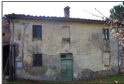
Foto: 05 Data ripresa: 21/02/2006 Edificio: 299 File: 299-05.JPG
