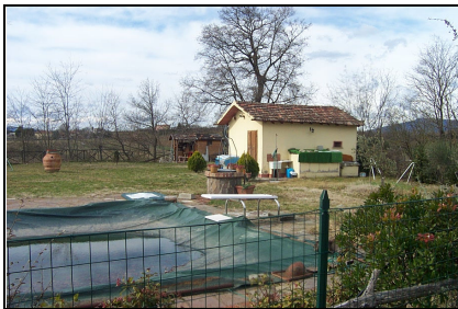
Foto: 04 Data ripresa: 24/02/2006 Edificio: 298/B File: 298-04.JPG
