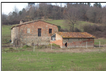
Foto: 07 Data ripresa: 24/02/2006 Edificio: 294/A File: 294-07.JPG
