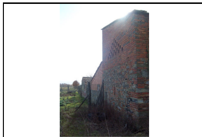
Foto: 08 Data ripresa: 17/02/2006 Edificio: 288/B File: 288-08.JPG
