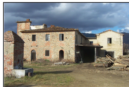
Foto: 03 Data ripresa: 17/02/2006 Edificio: 286 File: 286-03.JPG
