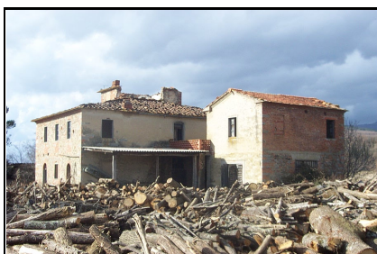
Foto: 10 Data ripresa: 17/02/2006 Edificio: 286 File: 286-10.JPG
