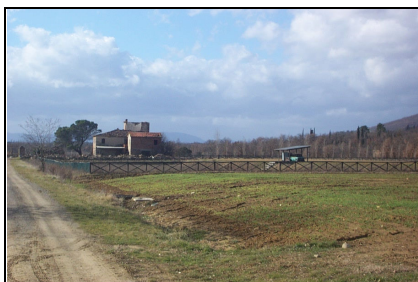
Foto: 01 Data ripresa: 17/02/2006 Edificio: 286 File: 286-01.JPG
