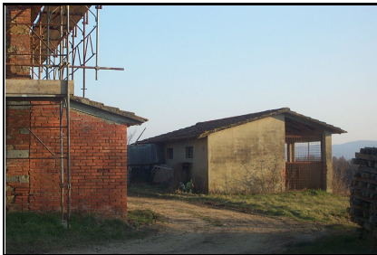
Foto: 07 Data ripresa: 14/02/2006 Edificio: 281/A File: 281-07.JPG
