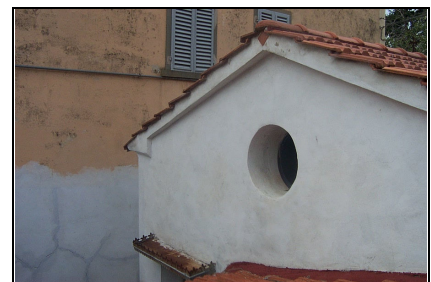
Foto: 15 Data ripresa: 27/03/2006 Edificio: 272/C File: 272-15.JPG
