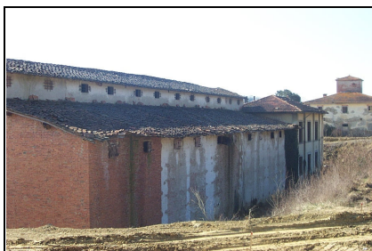
Foto: 04 Data ripresa: 14/02/2006 Edificio: 271 File: 271-04.JPG
