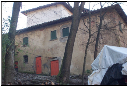
Foto: 16 Data ripresa: 10/02/2006 Edificio: 253 File: 253-16.JPG
