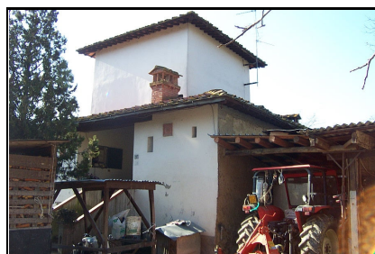
Foto: 12 Data ripresa: 10/02/2006 Edificio: 253/A File: 253-12.JPG
