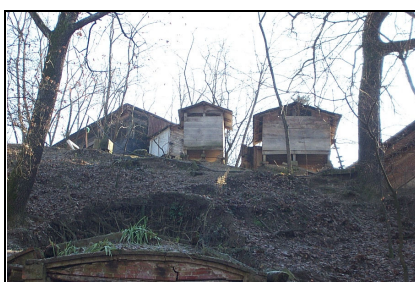
Foto: 14 Data ripresa: 10/02/2006 Edificio: 253/A File: 253-14.JPG
