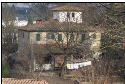
Foto: 01 Data ripresa: 10/02/2006 Edificio: 253 File: 253-01.JPG
