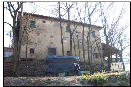
Foto: 18 Data ripresa: 10/02/2006 Edificio: 253 File: 253-18.JPG
