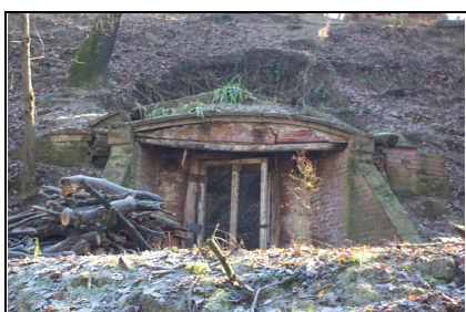
Foto: 13 Data ripresa: 10/02/2006 Edificio: 253/C File: 253-13.JPG
