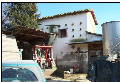
Foto: 11 Data ripresa: 10/02/2006 Edificio: 253/B File: 253-11.JPG
