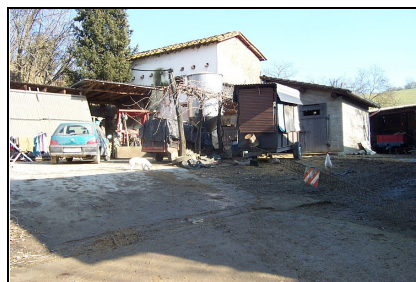
Foto: 06 Data ripresa: 10/02/2006 Edificio: 253/B File: 253-06.JPG
