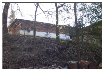
Foto: 15 Data ripresa: 10/02/2006 Edificio: 253/A File: 253-15.JPG
