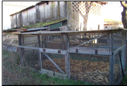
Foto: 05 Data ripresa: 11/01/2006 Edificio: 244 File: 244-05.JPG
