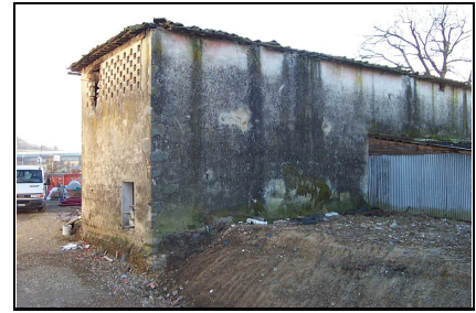
Foto: 03 Data ripresa: 11/01/2006 Edificio: 244 File: 244-03.JPG
