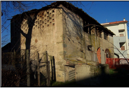
Foto: 01 Data ripresa: 11/01/2006 Edificio: 244 File: 244-01.JPG
