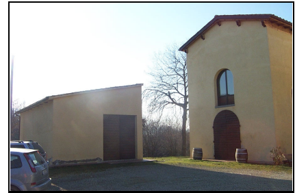
Foto: 03 Data ripresa: 14/02/2006 Edificio: 236/A File: 236-03.JPG
