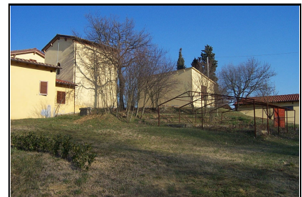
Foto: 12 Data ripresa: 14/02/2006 Edificio: 236/B File: 236-12.JPG
