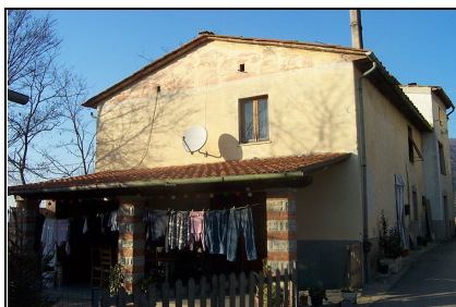
Foto: 04 Data ripresa: 14/02/2006 Edificio: 230/C File: 230-04.JPG
