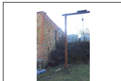
Foto: 06 Data ripresa: 14/02/2006 Edificio: 224/B File: 224-06.JPG
