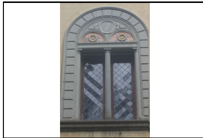
Foto: 11 Data ripresa: 27/03/2006 Edificio: 218 File: 218-11.JPG
