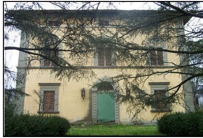
Foto: 02 Data ripresa: 27/03/2006 Edificio: 218 File: 218-02.JPG
