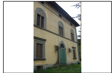
Foto: 06 Data ripresa: 27/03/2006 Edificio: 218 File: 218-06.JPG
