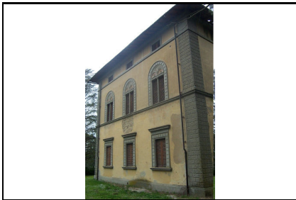
Foto: 10 Data ripresa: 27/03/2006 Edificio: 218 File: 218-10.JPG
