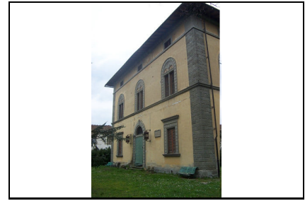
Foto: 03 Data ripresa: 27/03/2006 Edificio: 218 File: 218-03.JPG
