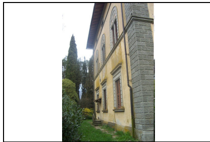
Foto: 05 Data ripresa: 27/03/2006 Edificio: 218 File: 218-05.JPG
