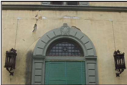
Foto: 07 Data ripresa: 27/03/2006 Edificio: 218 File: 218-07.JPG
