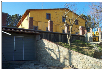
Foto: 20 Data ripresa: 10/02/2006 Edificio: 214/D File: 214-20.JPG
