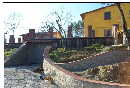
Foto: 21 Data ripresa: 10/02/2006 Edificio: 214/D File: 214-21.JPG
