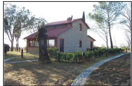
Foto: 06 Data ripresa: 10/02/2006 Edificio: 214/A File: 214-06.JPG
