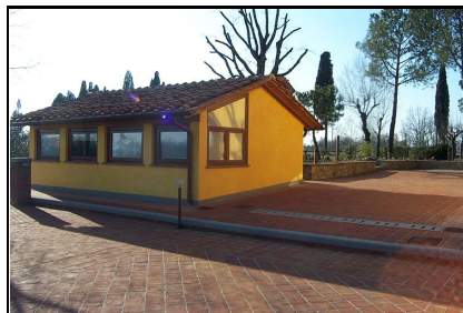
Foto: 11 Data ripresa: 10/02/2006 Edificio: 214/B File: 214-11.JPG
