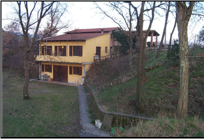
Foto: 16 Data ripresa: 14/02/2006 Edificio: 213/B File: 213-16.JPG
