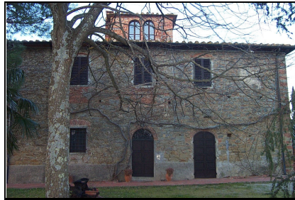
Foto: 02 Data ripresa: 14/02/2006 Edificio: 213 File: 213-02.JPG
