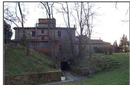
Foto: 15 Data ripresa: 14/02/2006 Edificio: 213 File: 213-15.JPG
