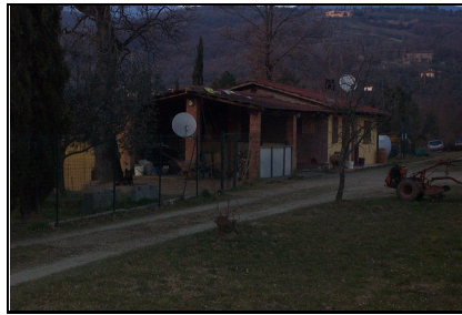
Foto: 17 Data ripresa: 14/02/2006 Edificio: 213/B File: 213-17.JPG
