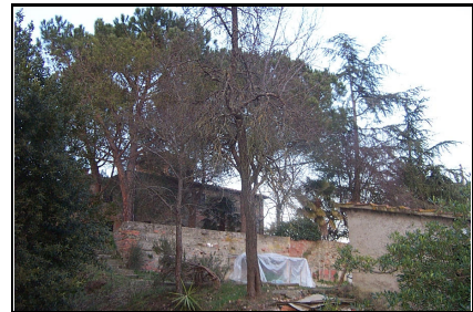
Foto: 09 Data ripresa: 14/02/2006 Edificio: 213/C File: 213-09.JPG
