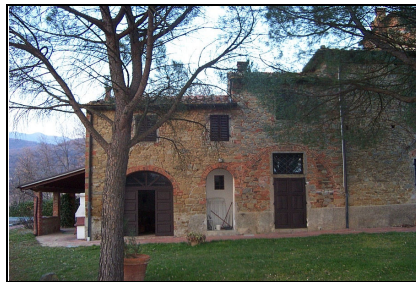
Foto: 05 Data ripresa: 14/02/2006 Edificio: 213/A File: 213-05.JPG
