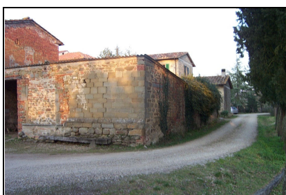
Foto: 14 Data ripresa: 08/02/2006 Edificio: 212/B File: 212-14.JPG
