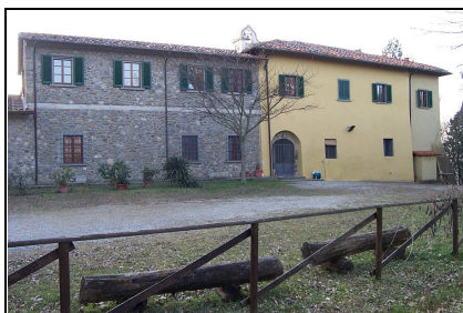
Foto: 04 Data ripresa: 08/02/2006 Edificio: 212/A File: 212-04.JPG
