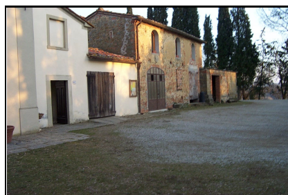
Foto: 12 Data ripresa: 08/02/2006 Edificio: 212/B File: 212-12.JPG
