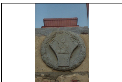
Foto: 13 Data ripresa: 08/02/2006 Edificio: 212/B File: 212-13.JPG
