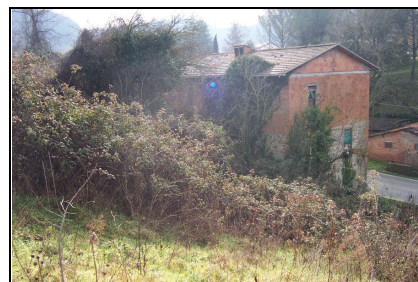
Foto: 03 Data ripresa: 03/01/2006 Edificio: 207 File: 207-03.JPG
