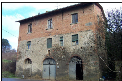
Foto: 01 Data ripresa: 03/01/2006 Edificio: 207 File: 207-01.JPG
