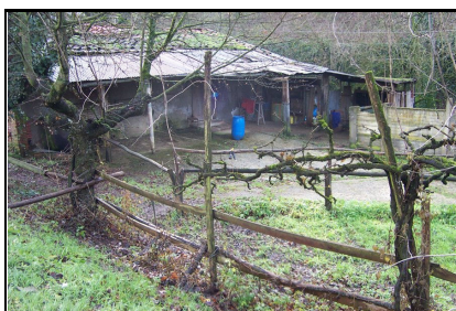
Foto: 08 Data ripresa: 03/01/2006 Edificio: 207 File: 207-08.JPG
