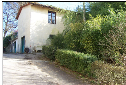
Foto: 05 Data ripresa: 08/02/2006 Edificio: 201 File: 201-05.JPG
