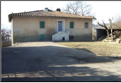
Foto: 16 Data ripresa: 08/02/2006 Edificio: 201 File: 201-16.JPG
