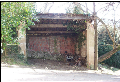
Foto: 07 Data ripresa: 08/02/2006 Edificio: 201/B File: 201-07.JPG
