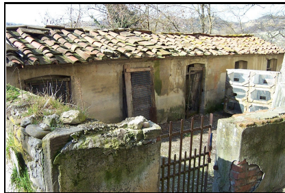
Foto: 08 Data ripresa: 08/02/2006 Edificio: 201/A File: 201-08.JPG
