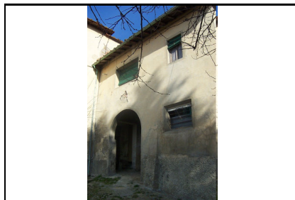
Foto: 11 Data ripresa: 08/02/2006 Edificio: 201 File: 201-11.JPG
