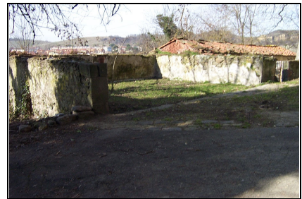
Foto: 06 Data ripresa: 08/02/2006 Edificio: 201/A File: 201-06.JPG
