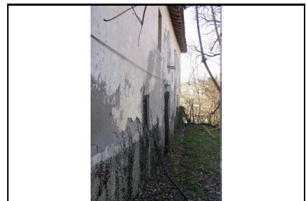
Foto: 12 Data ripresa: 08/02/2006 Edificio: 201 File: 201-12.JPG
