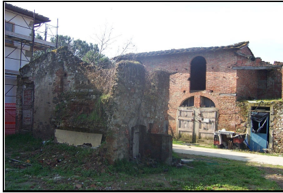
Foto: 17 Data ripresa: 27/03/2006 Edificio: 173/B File: 173-17.JPG
