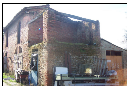
Foto: 15 Data ripresa: 27/03/2006 Edificio: 173/B File: 173-15.JPG
