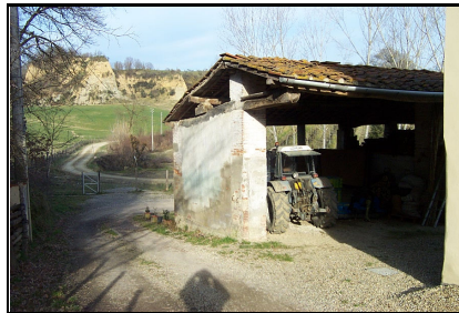
Foto: 08 Data ripresa: 08/02/2006 Edificio: 171/B File: 171-08.JPG
