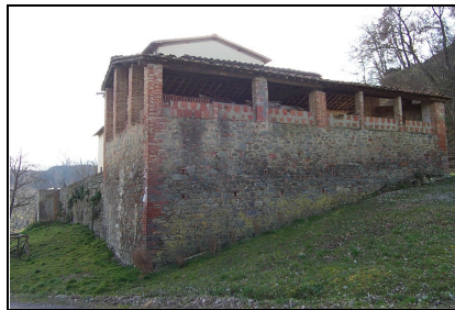
Foto: 05 Data ripresa: 08/02/2006 Edificio: 171/B File: 171-05.JPG
