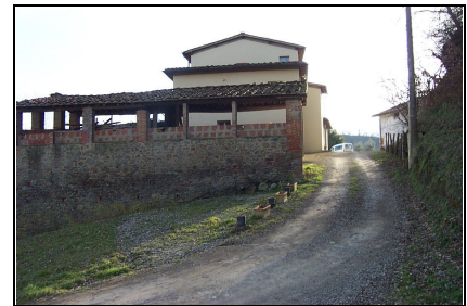
Foto: 06 Data ripresa: 08/02/2006 Edificio: 171/B File: 171-06.JPG
