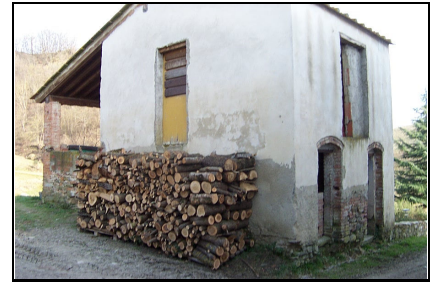
Foto: 06 Data ripresa: 08/02/2006 Edificio: 170/B File: 170-06.JPG
