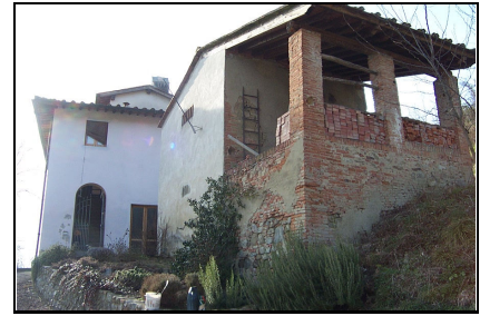
Foto: 03 Data ripresa: 08/02/2006 Edificio: 170/B File: 170-03.JPG
