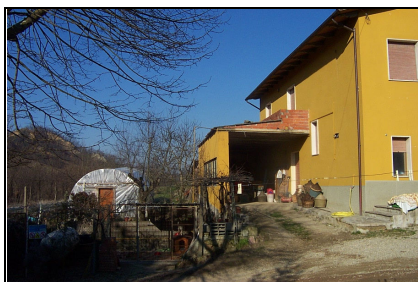
Foto: 04 Data ripresa: 14/02/2006 Edificio: 169 File: 169-04.JPG
