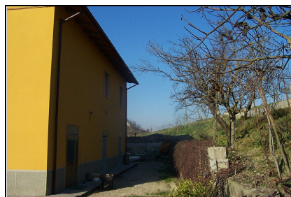
Foto: 06 Data ripresa: 14/02/2006 Edificio: 169 File: 169-06.JPG
