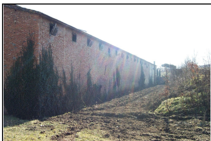
Foto: 04 Data ripresa: 14/02/2006 Edificio: 168 File: 168-04.JPG
