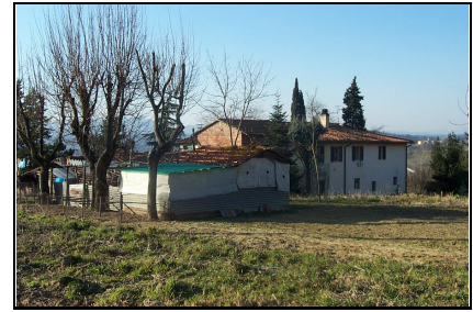
Foto: 03 Data ripresa: 14/02/2006 Edificio: 163/C File: 163-03.JPG
