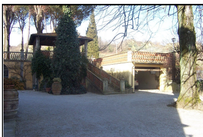
Foto: 10 Data ripresa: 08/02/2006 Edificio: 148/A File: 148-10.JPG
