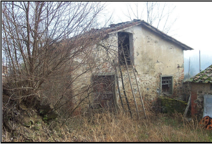
Foto: 16 Data ripresa: 06/02/2006 Edificio: 147/B File: 147-16.JPG
