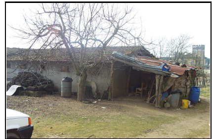
Foto: 09 Data ripresa: 06/02/2006 Edificio: 147/D File: 147-09.JPG
