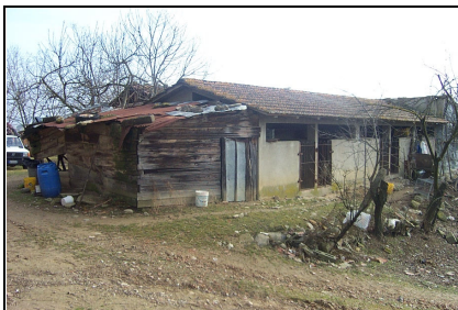
Foto: 13 Data ripresa: 06/02/2006 Edificio: 147/D File: 147-13.JPG
