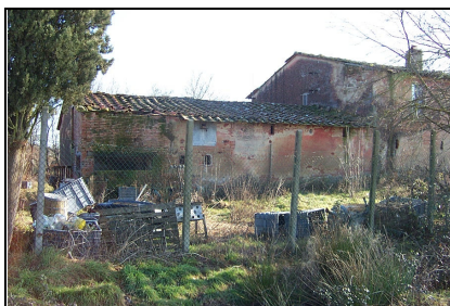
Foto: 05 Data ripresa: 10/02/2006 Edificio: 136 File: 136-05.JPG
