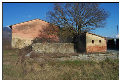
Foto: 09 Data ripresa: 10/02/2006 Edificio: 136/A File: 136-09.JPG
