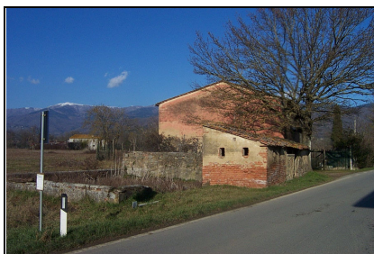
Foto: 02 Data ripresa: 10/02/2006 Edificio: 136/A File: 136-02.JPG
