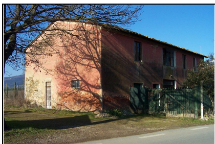
Foto: 01 Data ripresa: 10/02/2006 Edificio: 136 File: 136-01.JPG
