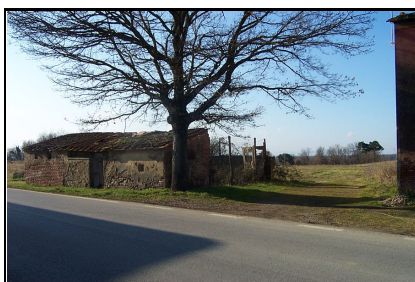
Foto: 08 Data ripresa: 10/02/2006 Edificio: 136/A File: 136-08.JPG
