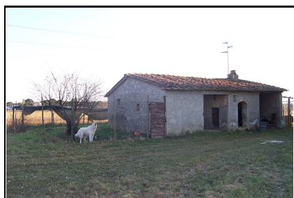
Foto: 07 Data ripresa: 14/02/2006 Edificio: 134/B File: 134-07.JPG
