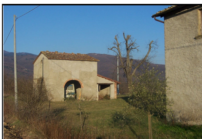
Foto: 08 Data ripresa: 14/02/2006 Edificio: 134/A File: 134-08.JPG
