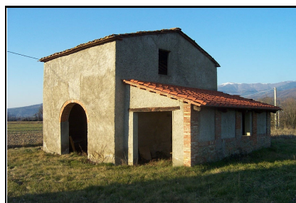
Foto: 09 Data ripresa: 14/02/2006 Edificio: 134/A File: 134-09.JPG
