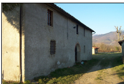
Foto: 02 Data ripresa: 14/02/2006 Edificio: 134 File: 134-02.JPG
