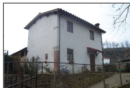
Foto: 03 Data ripresa: 06/02/2006 Edificio: 133/C File: 133-03.JPG
