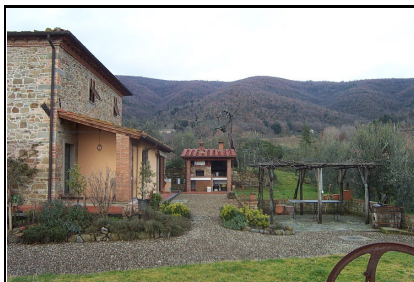
Foto: 08 Data ripresa: 20/02/2006 Edificio: 131/B File: 131-08.JPG
