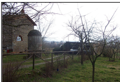
Foto: 14 Data ripresa: 20/02/2006 Edificio: 131/A File: 131-14.JPG
