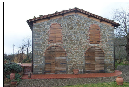
Foto: 09 Data ripresa: 20/02/2006 Edificio: 131/A File: 131-09.JPG
