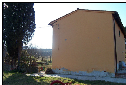
Foto: 06 Data ripresa: 21/02/2006 Edificio: 121 File: 121-06.JPG
