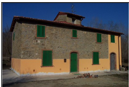
Foto: 01 Data ripresa: 21/02/2006 Edificio: 121 File: 121-01.JPG
