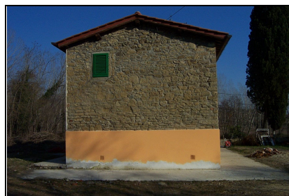
Foto: 03 Data ripresa: 21/02/2006 Edificio: 121 File: 121-03.JPG
